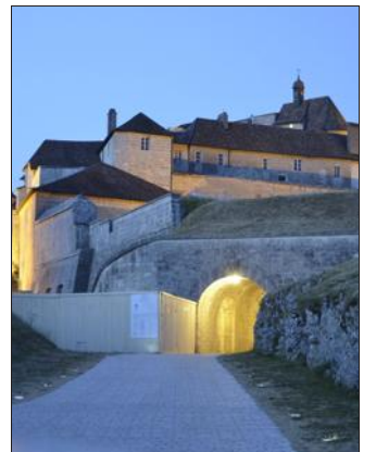
■ Des travaux effectués sur la route accédant au château.
