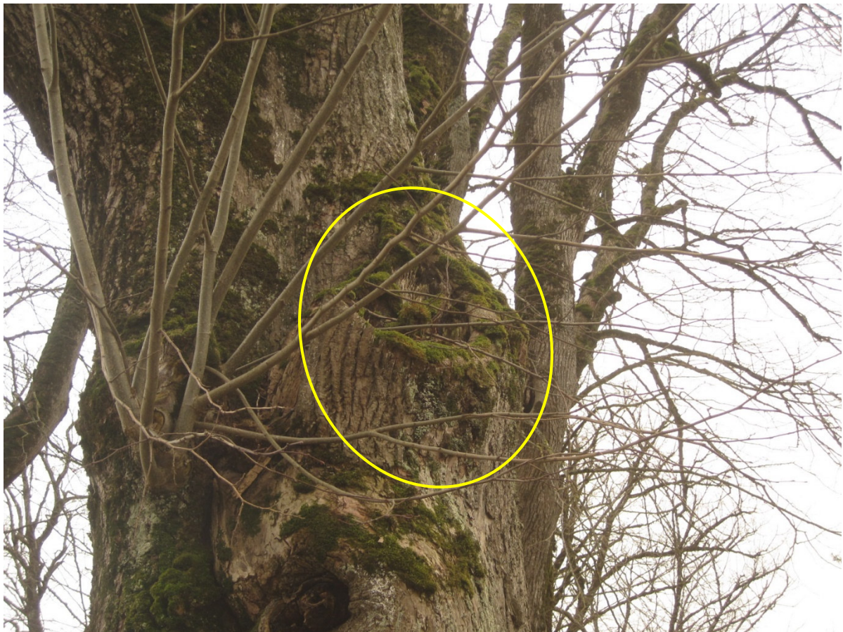
Antécédent de rupture d'une charpentière
