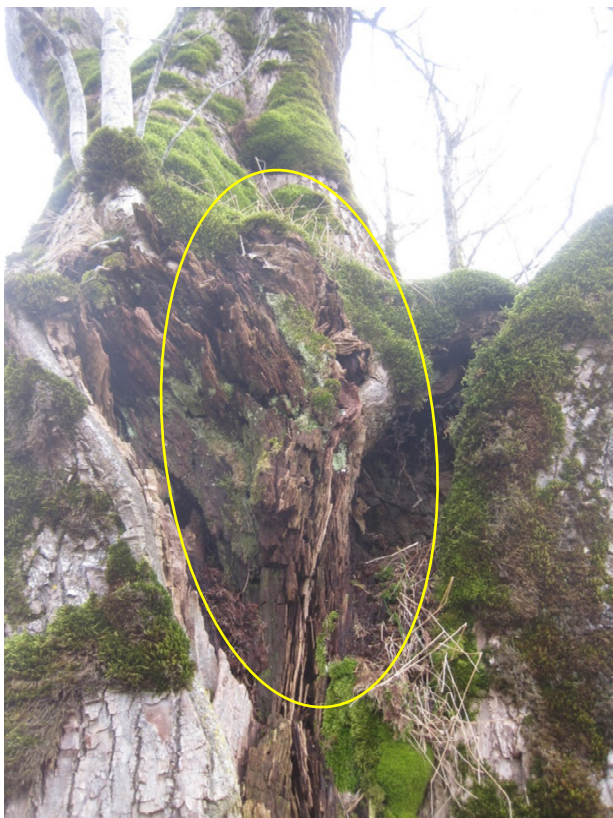
Insertion de la charpentière 30 grades
